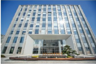
项目名称 南京法德东恒大厦 项目地点 南京 应用产品品类 数字通信综合布线全链路产品、数据电缆.....
