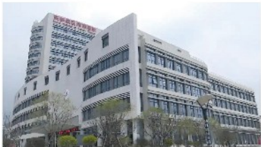
项目名称 中国人民解放军东部战区 海军医院综合布线工程 项目地点 杭州 应用产品品类 数据电缆.....
