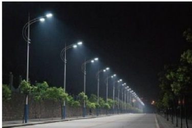
项目名称 重庆市江北区市政路灯节能改造工程
