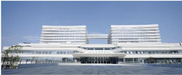
项目名称 四川大学华西医院锦江院区弱电工程项目 项目地点 成都 应用产品品类 数字通信综合布线全链路产品、数据电缆、智控电源线缆.....
