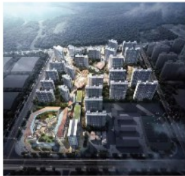
项目名称 武汉光谷青年社区智能化项目 项目地点 武汉 应用产品品类 光通信综合布线全链路产品、智控电源线缆.....
