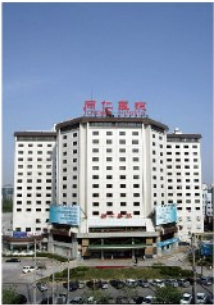
项目名称 首都医科大学附属北京同仁医院 智能化改造项目 项目地点 北京 应用产品品类 数字通信综合布线全链路产品、 数据电缆.....
