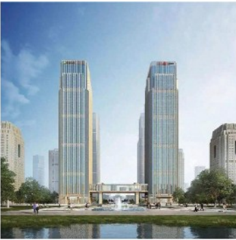
项目名称 广发银行总部大楼 项目地点 广州 应用产品品类 光通信综合布线链路产品
