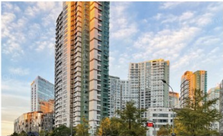
项目名称 新城国际五期智慧社区改造工程 项目地点 郑州 应用产品品类 数据电缆、智控电源线缆.....
