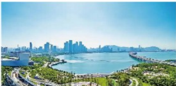
项目名称 深圳前海深港合作区人才安居智慧社区建设 项目地点 深圳 应用产品品类 数据电缆、智控电源线缆.....
