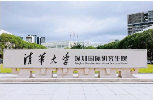
项目名称 清华大学国际研究生院项目 项目地点 深圳 应用产品品类 数字通信综合布线全链路产品...
