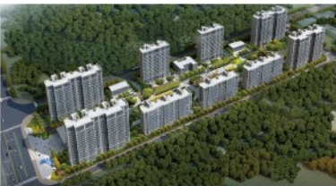
项目名称 山河章智慧社区综合布线项目 项目地点 石家庄 应用产品品类 数据电缆、智控电源线缆.....
