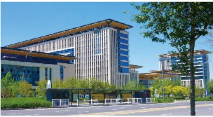
项目名称 新疆国际医疗中心建设工程 项目地点 乌鲁木齐 应用产品品类 数据电缆.....
