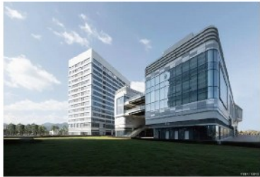
项目名称 港产城数智大厦 项目地点 天津 应用产品品类 数据电缆、智控信号线缆.....
