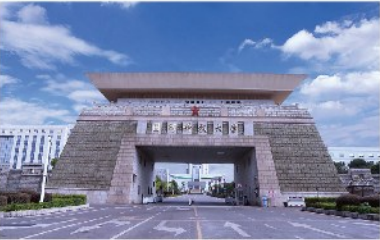
项目名称 中国人民解放军国防科技大学 信息化升级项目 项目地点 长沙 应用产品品类 光通信综合布线全链路产品、通信光缆.....
