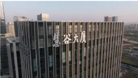
项目名称 武汉慧谷大厦 项目地点 武汉 应用产品品类 数据电缆、智控电源线缆.....
